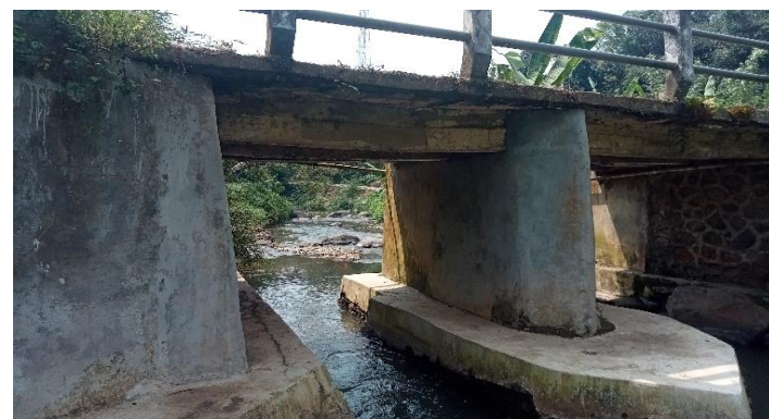
KONDISI BANGUNAN BAWAH
