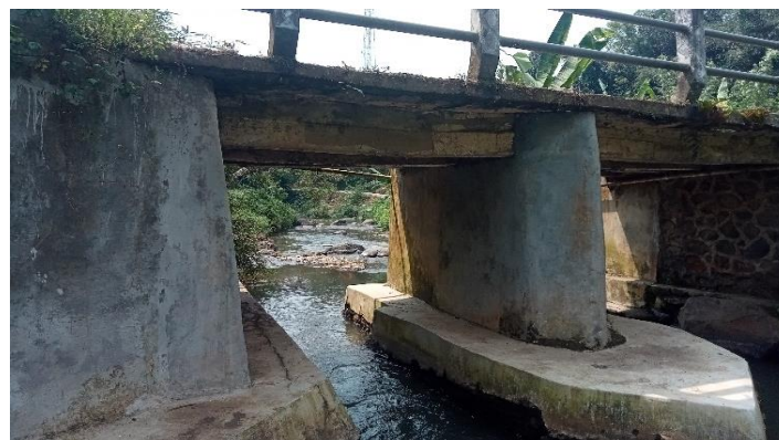
KONDISI BANGUNAN BAWAH
