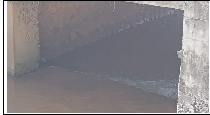
KONDISI BANGUNAN BAWAH
