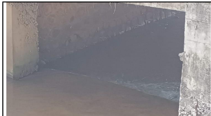
KONDISI BANGUNAN BAWAH
