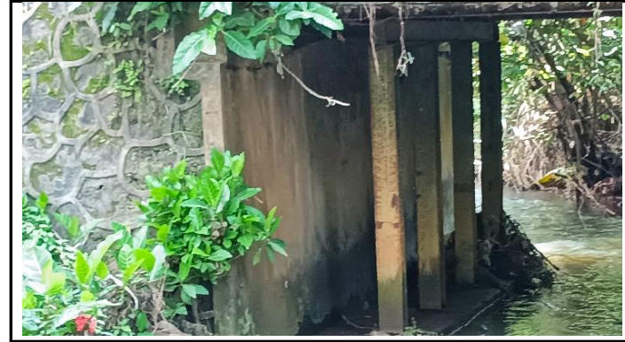
KONDISI KEPALA JEMBATAN
