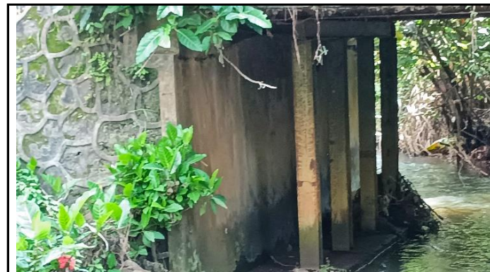
KONDISI KEPALA JEMBATAN
