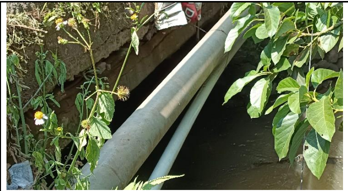
KONDISI PIPA UTILITAS AIR MINUM
