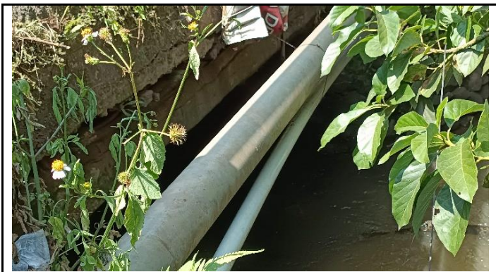
KONDISI PIPA UTILITAS AIR MINUM
