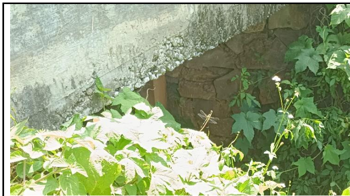
KONDISI BANGUNAN BAWAH
