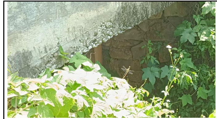
KONDISI BANGUNAN BAWAH
