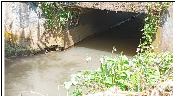
KONDISI BANGUNAN BAWAH
