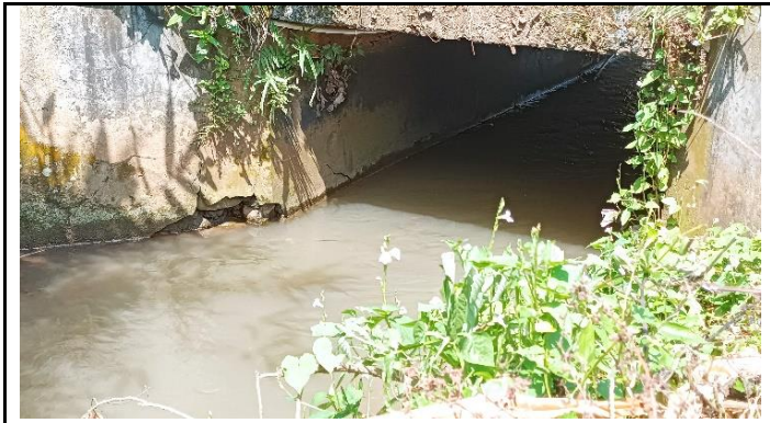
KONDISI BANGUNAN BAWAH
