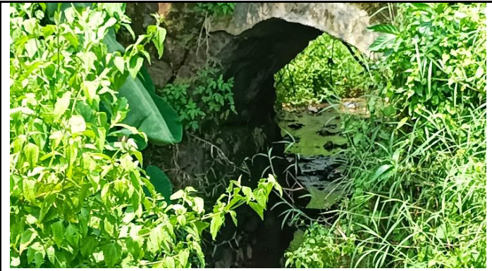
KONDISI BANGUNAN BAWAH
