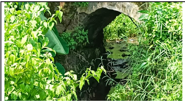
KONDISI BANGUNAN BAWAH
