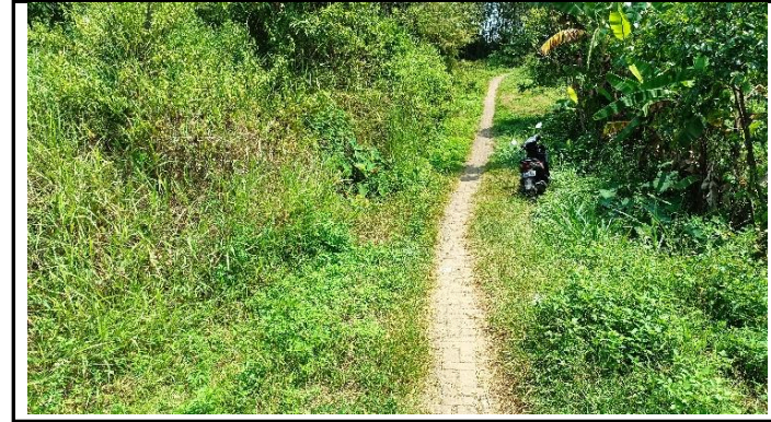
KONDISI JALAN PENDEKAT
