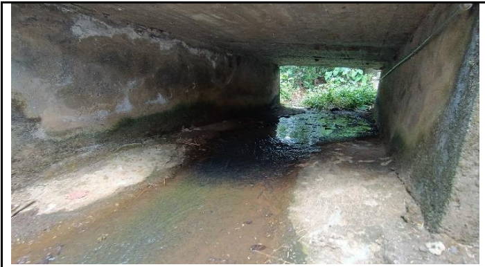
KONDISI BANGUNAN BAWAH
