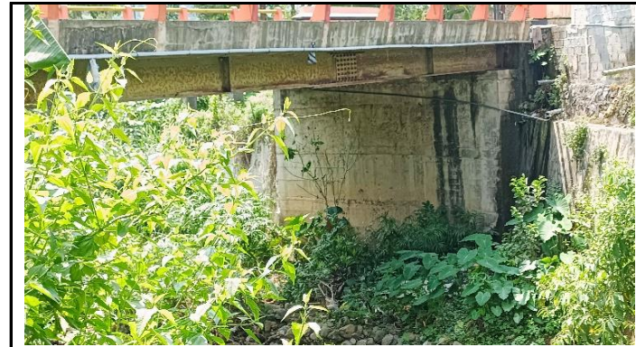
KONDISI BANGUNAN BAWAH DAN GELAGAR KOMPOSIT
