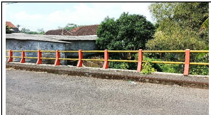
KONDISI SANDARAN JEMBATAN
