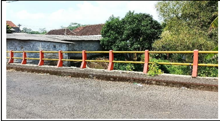
KONDISI SANDARAN JEMBATAN
