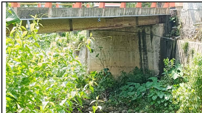
KONDISI BANGUNAN BAWAH DAN GELAGAR KOMPOSIT
