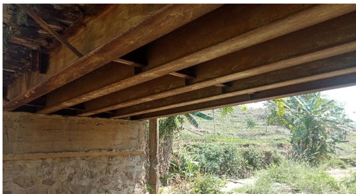
KONDISI BANGUNAN BAWAH
