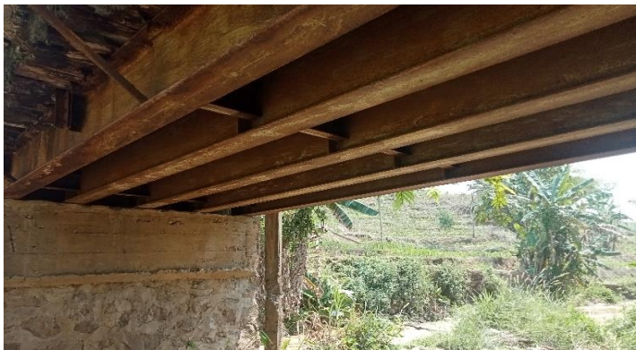
KONDISI BANGUNAN BAWAH
