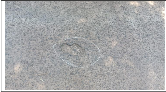
LAPISAN PERMUKAAN LANTAI BERLUBANG
