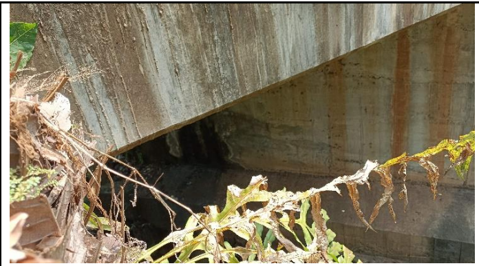
KONDISI KEPALA JEMBATAN
