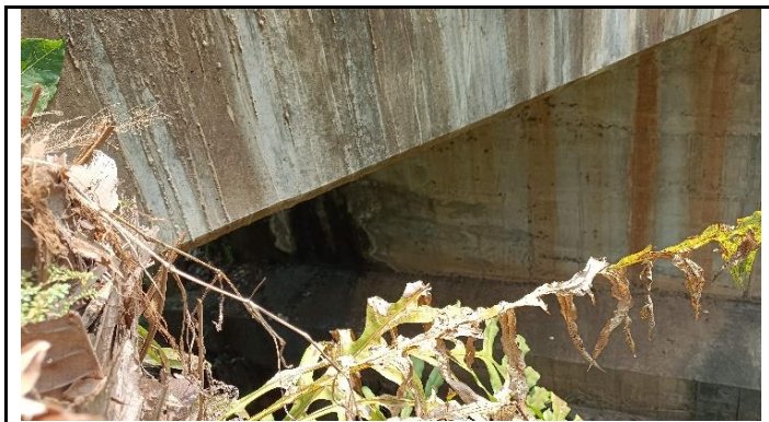
KONDISI KEPALA JEMBATAN
