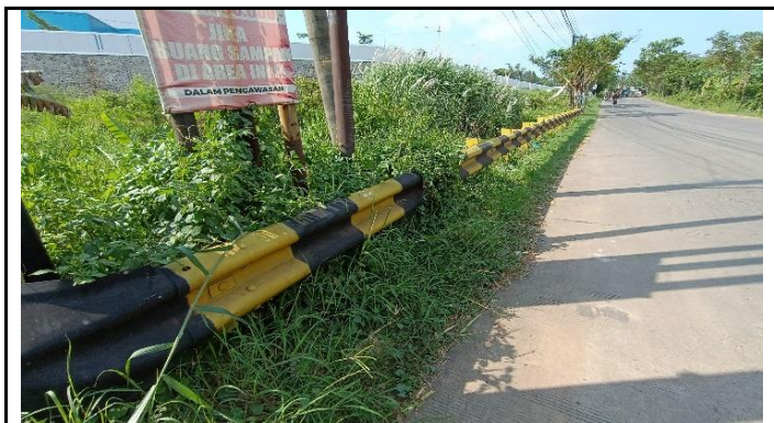
KONDISI PENGAMAN JALAN PENDEKAT (GUARD RAILL)
