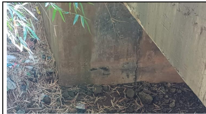
KONDISI KEPALA JEMBATAN
