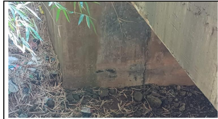
KONDISI KEPALA JEMBATAN
