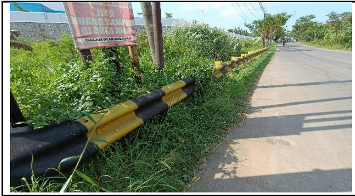
KONDISI PENGAMAN JALAN PENDEKAT (GUARD RAILL)
