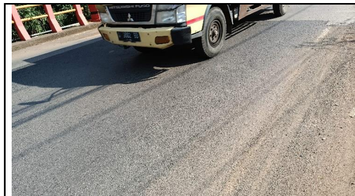
KONDISI LAPISAN PERMUKAAN LANTAI
