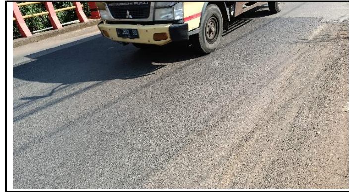
KONDISI LAPISAN PERMUKAAN LANTAI
