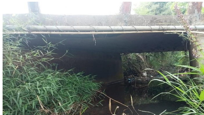
KONDISI BANGUNAN BAWAH
