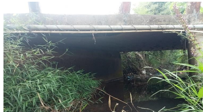
KONDISI BANGUNAN BAWAH
