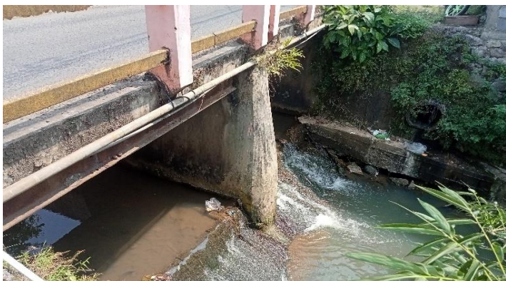
KONDISI BANGUNAN BAWAH
