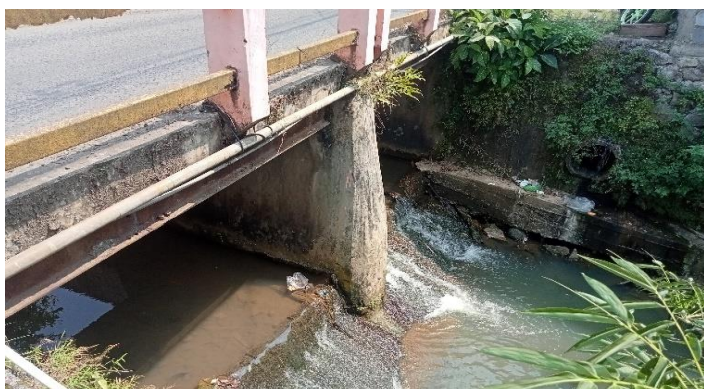
KONDISI BANGUNAN BAWAH
