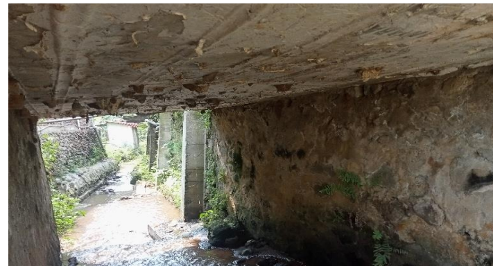
KONDISI BANGUNAN BAWAH
