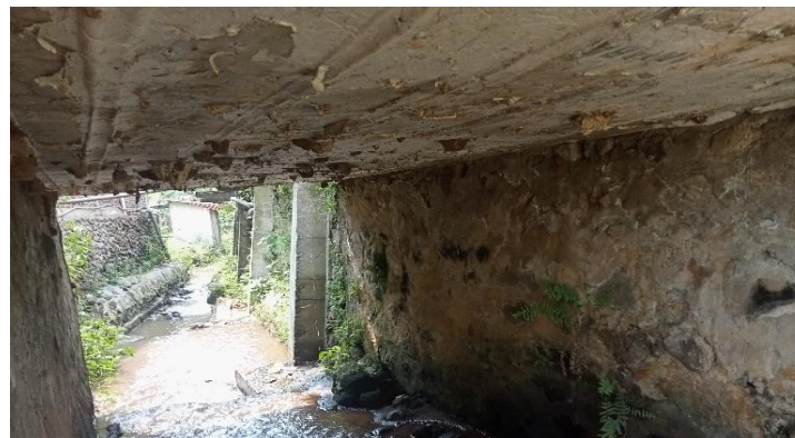
KONDISI BANGUNAN BAWAH
