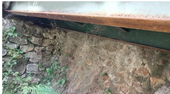
KONDISI BANGUNAN BAWAH
