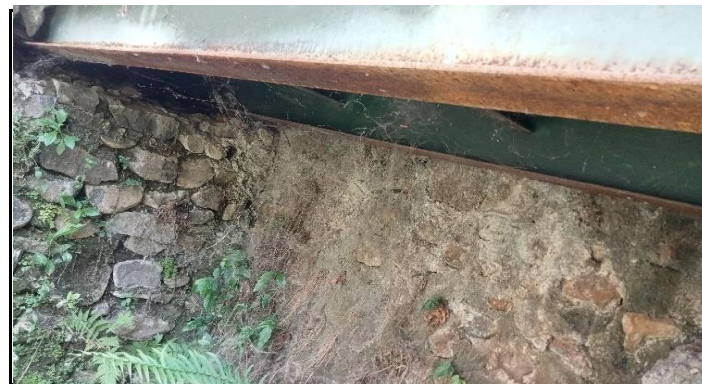
KONDISI BANGUNAN BAWAH
