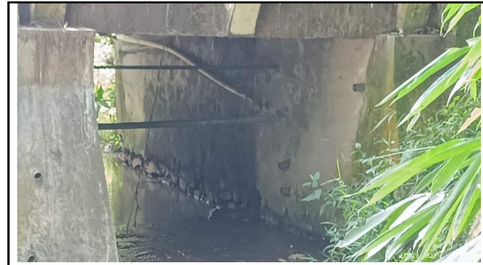
KONDISI BANGUNAN BAWAH
