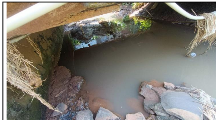
KONDISI BANGUNAN BAWAH
