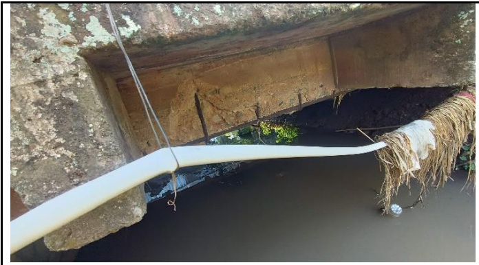
KONDISI PIPA UTILITAS AIR MINUM
