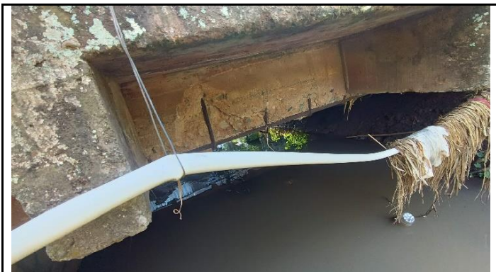
KONDISI PIPA UTILITAS AIR MINUM
