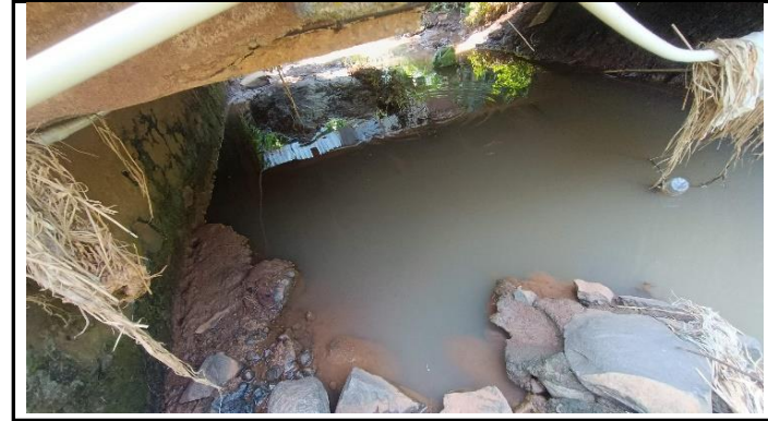
KONDISI BANGUNAN BAWAH
