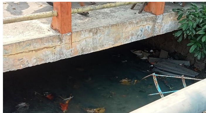
KONDISI BANGUNAN BAWAH
