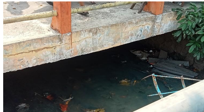
KONDISI BANGUNAN BAWAH
