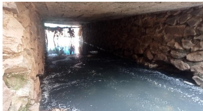
KONDISI BANGUNAN BAWAH
