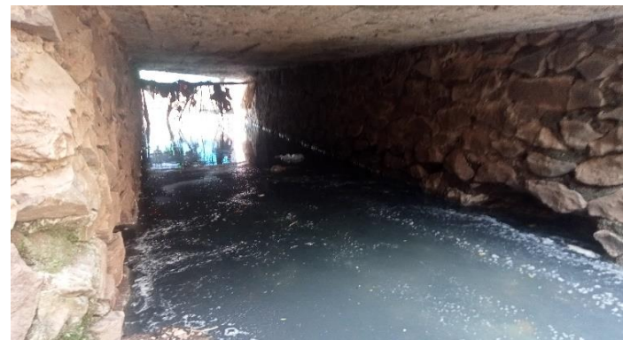
KONDISI BANGUNAN BAWAH
