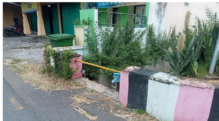
KONDISI SANDARAN DAN PARAPET
