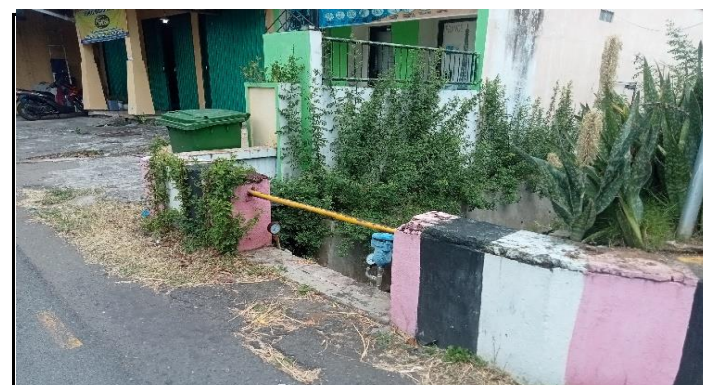
KONDISI SANDARAN DAN PARAPET
