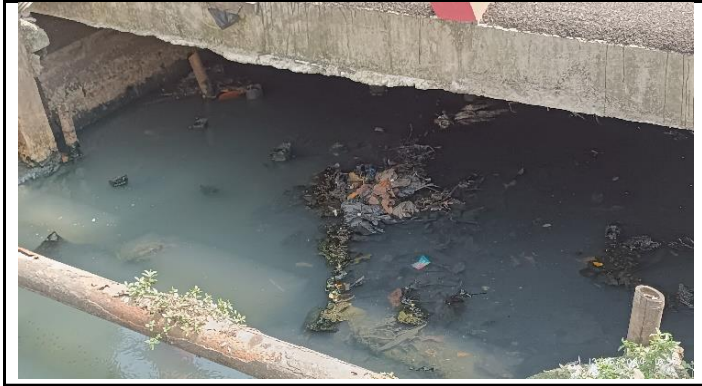
KONDISI BANGUNAN BAWAH
