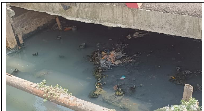
KONDISI BANGUNAN BAWAH
