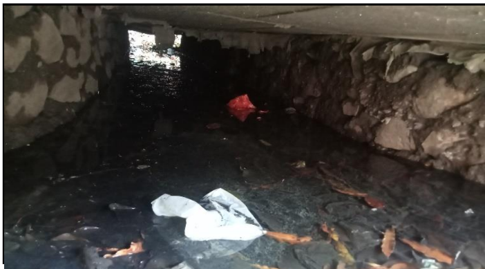
KONDISI BANGUNAN BAWAH
