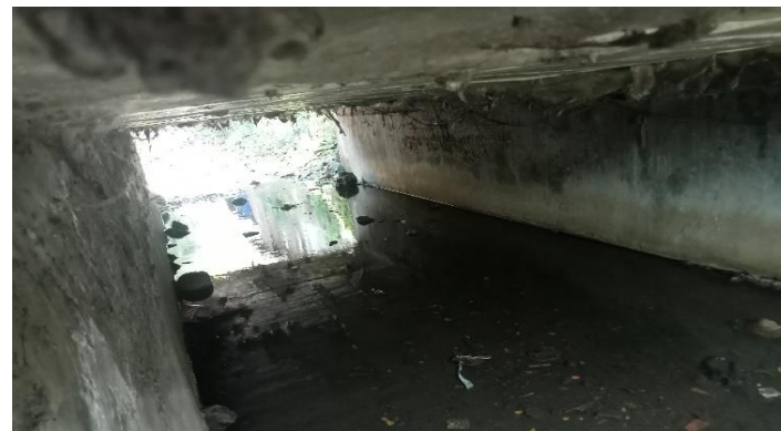
KONDISI BANGUNAN BAWAH
