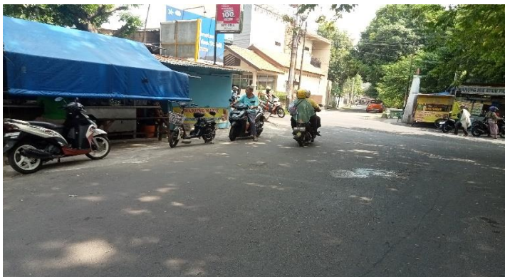
KONDISI LAPISAN PERMUKAAN LANTAI
