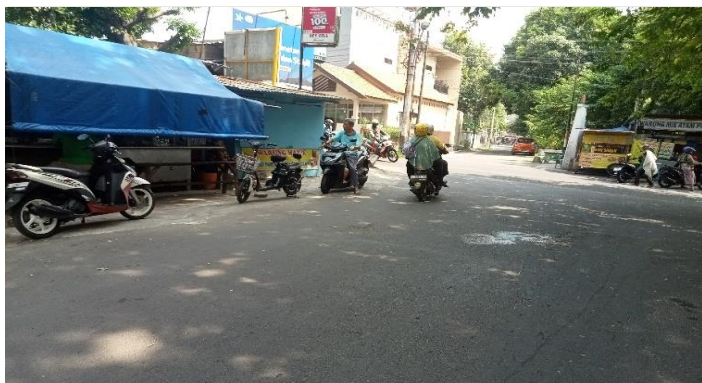
KONDISI LAPISAN PERMUKAAN LANTAI
