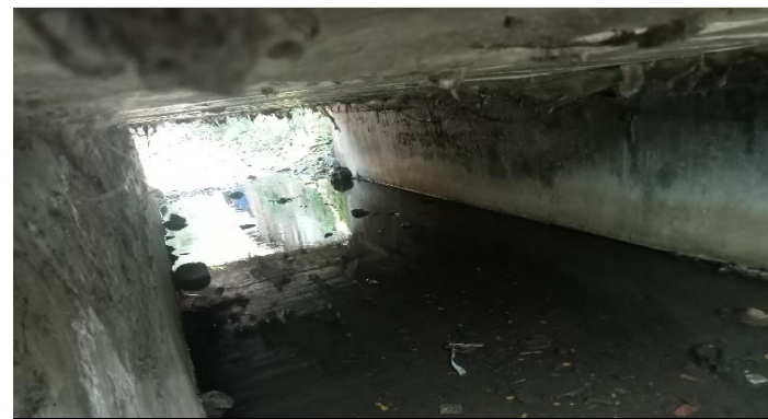
KONDISI BANGUNAN BAWAH
