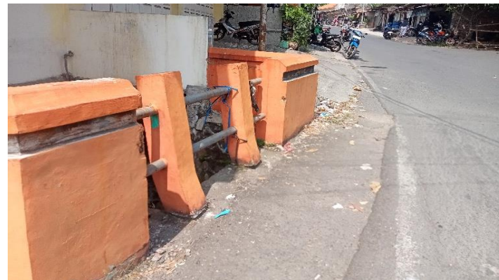
KONDISI SANDARAN RAILING
