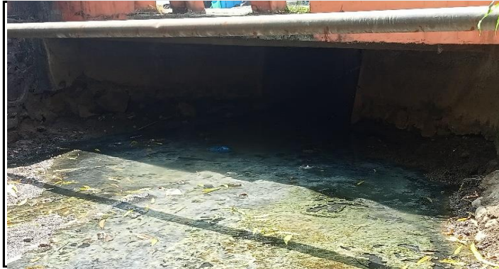
KONDISI BANGUNAN BAWAH
