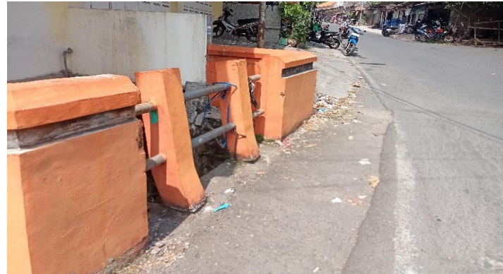
KONDISI SANDARAN RAILING
