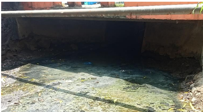
KONDISI BANGUNAN BAWAH
