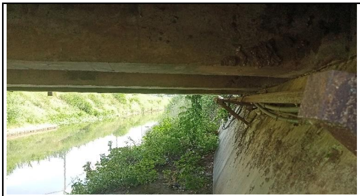
KONDISI KEPALA JEMBATAN DAN GELAGAR
