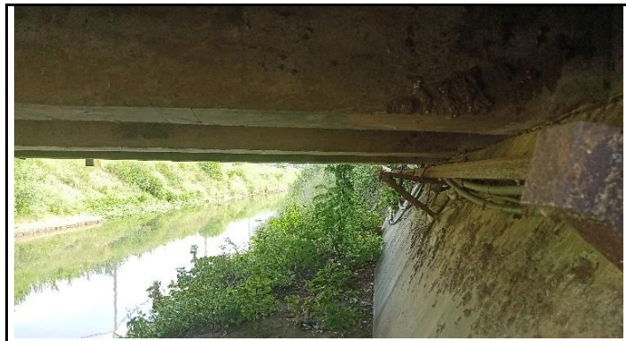
KONDISI KEPALA JEMBATAN DAN GELAGAR
