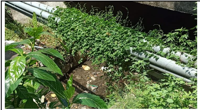
KONDISI PIPA UTILITAS AIR MINUM
