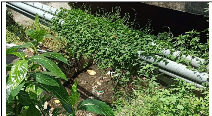
KONDISI PIPA UTILITAS AIR MINUM
