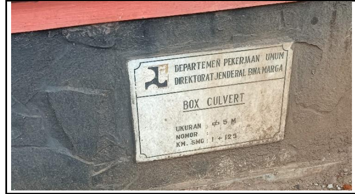
PAPAN NAMA JEMBATAN
