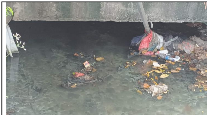
KONDISI BANGUNAN BAWAH
