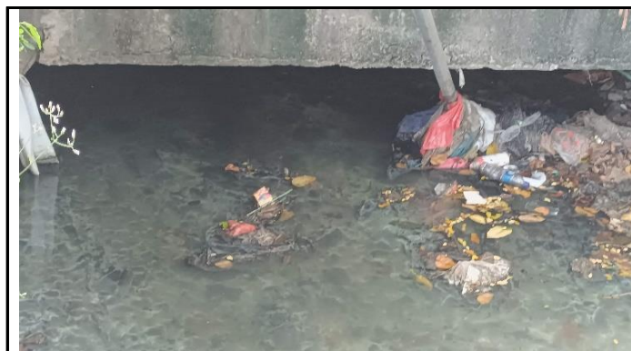
KONDISI BANGUNAN BAWAH
