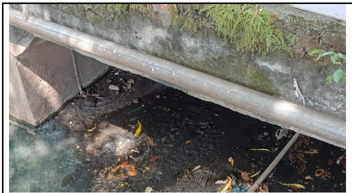
KONDISI PIPA UTILITAS AIR MINUM
