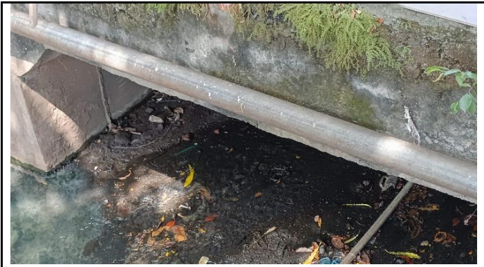
KONDISI PIPA UTILITAS AIR MINUM
