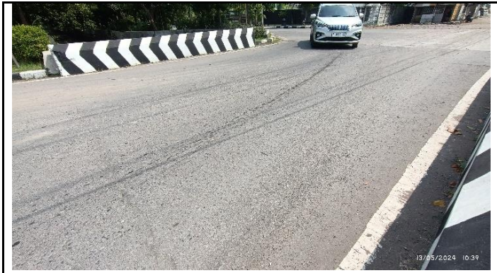
KONDISI LAPISAN PERMUKAAN LANTAI
