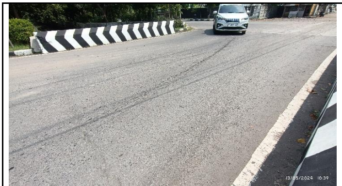
KONDISI LAPISAN PERMUKAAN LANTAI
