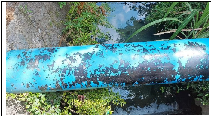
KONDISI PIPA UTILITAS AIR MINUM
