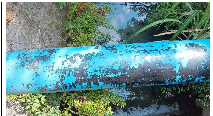
KONDISI PIPA UTILITAS AIR MINUM
