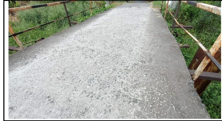
KONDISI LANTAI JEMBATAN
