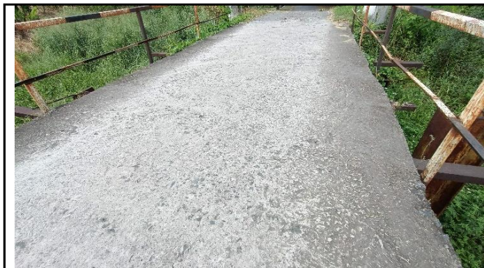
KONDISI LANTAI JEMBATAN
