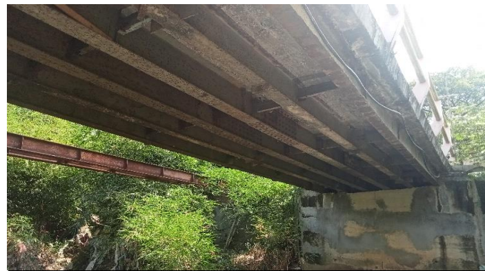
KONDISI BANGUNAN BAWAH
