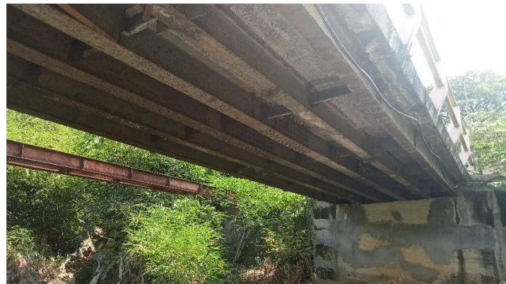
KONDISI BANGUNAN BAWAH
