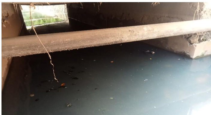
KONDISI BANGUNAN BAWAH
