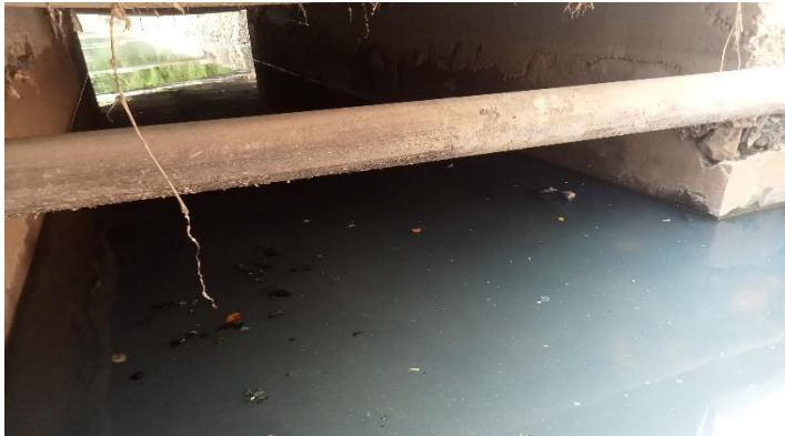
KONDISI BANGUNAN BAWAH
