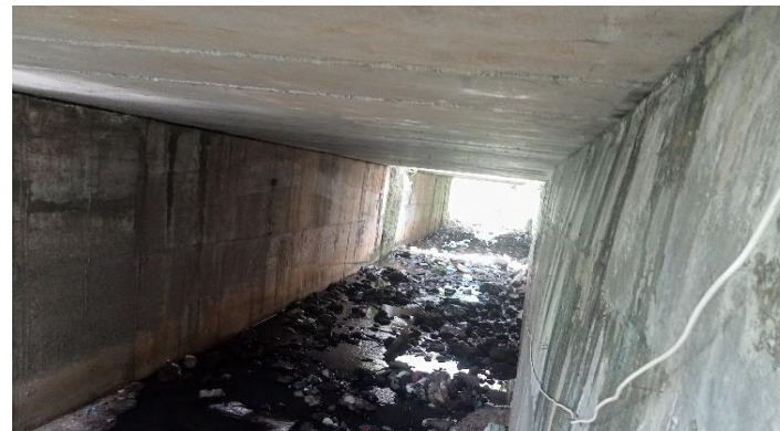
KONDISI BANGUNAN BAWAH
