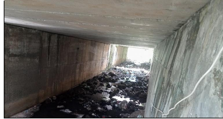
KONDISI BANGUNAN BAWAH
