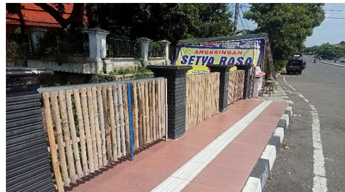
KONDISI SANDARAN DAN TROTOAR/KERB
