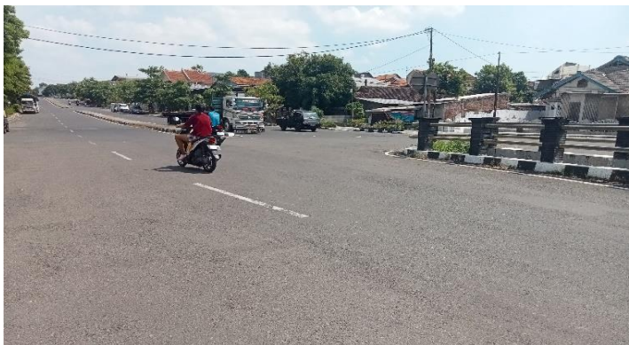
KONDISI LAPISAN PERMUKAAN LANTAI
