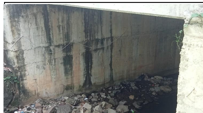
KONDISI BANGUNAN BAWAH
