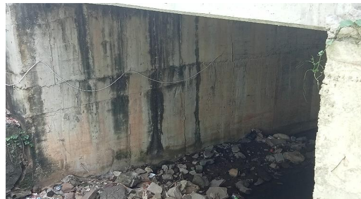
KONDISI BANGUNAN BAWAH
