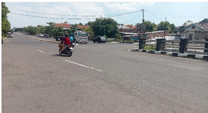
KONDISI LAPISAN PERMUKAAN LANTAI
