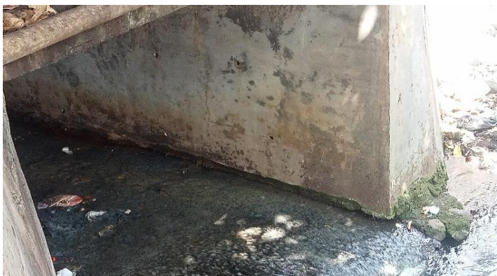
KONDISI BANGUNAN BAWAH
