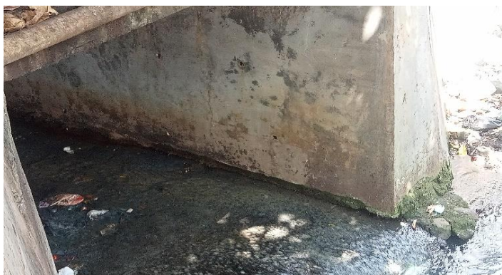
KONDISI BANGUNAN BAWAH
