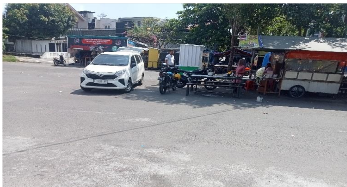
KONDISI LAPISAN PERMUKAAN LANTAI
