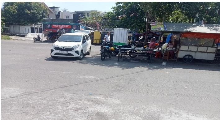
KONDISI LAPISAN PERMUKAAN LANTAI
