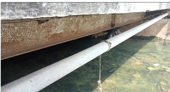
KONDISI BANGUNAN BAWAH
