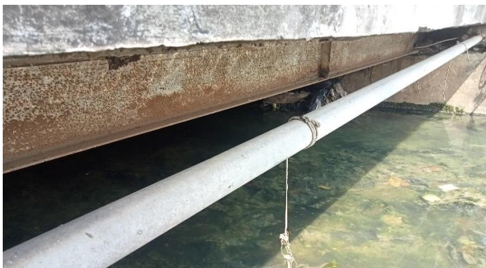
KONDISI BANGUNAN BAWAH
