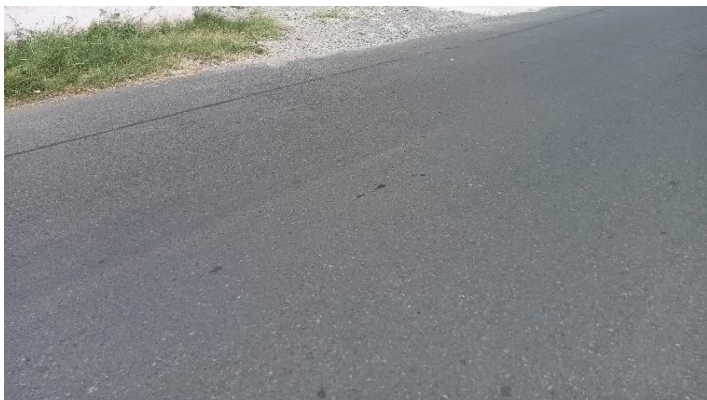
KONDISI LAPISAN PERMUKAAN LANTAI
