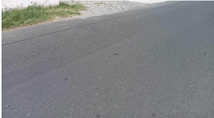
KONDISI LAPISAN PERMUKAAN LANTAI
