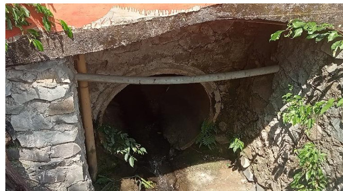
KONDISI BANGUNAN BAWAH
