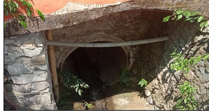
KONDISI BANGUNAN BAWAH
