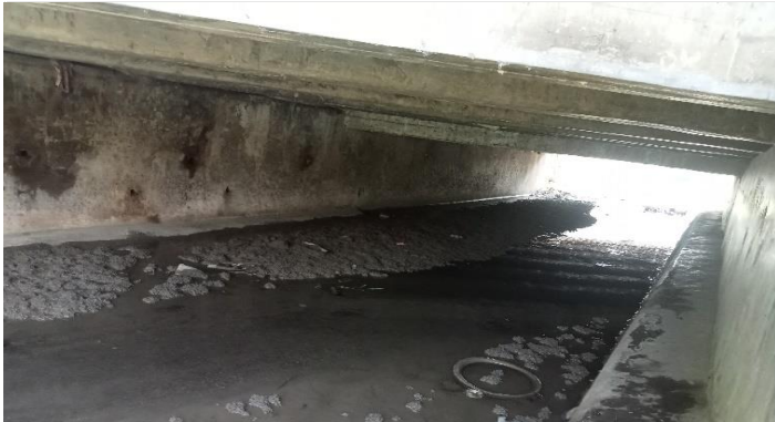
KONDISI BANGUNAN BAWAH
