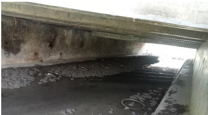
KONDISI BANGUNAN BAWAH
