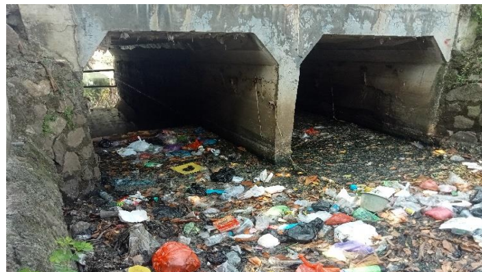
KONDISI BANGUNAN BAWAH
