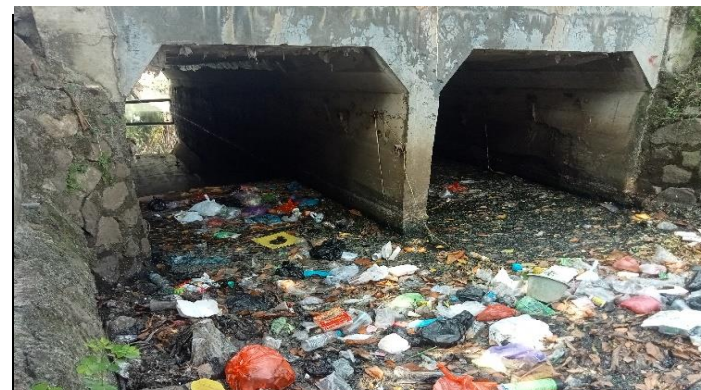
KONDISI BANGUNAN BAWAH
