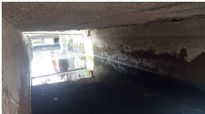
KONDISI BANGUNAN BAWAH
