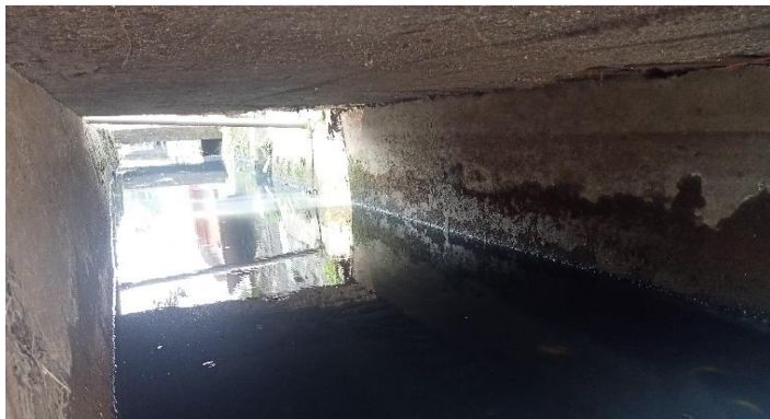
KONDISI BANGUNAN BAWAH
