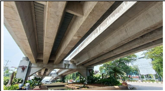
BATAS ATAS JEMBATAN (FLY OVER)
