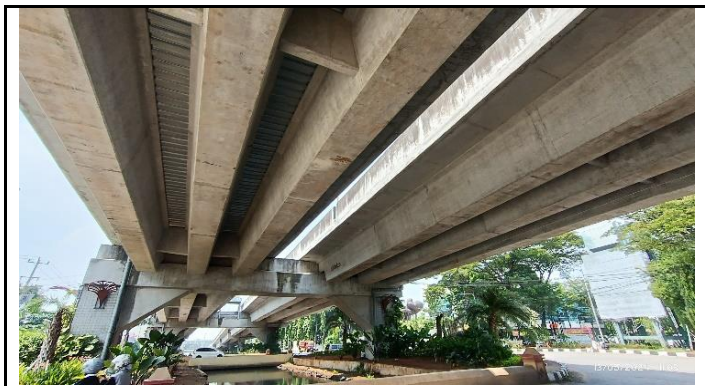
BATAS ATAS JEMBATAN (FLY OVER)
