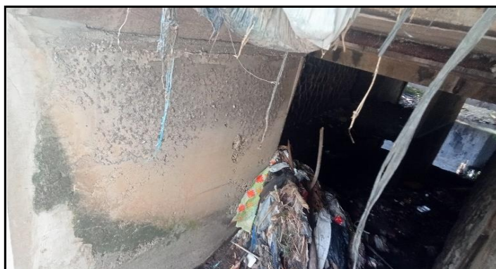
KONDISI BANGUNAN BAWAH
