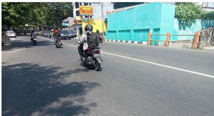
KONDISI LAPISAN PERMUKAAN LANTAI
