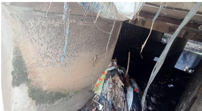
KONDISI BANGUNAN BAWAH
