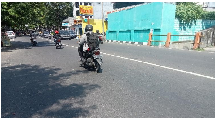
KONDISI LAPISAN PERMUKAAN LANTAI
