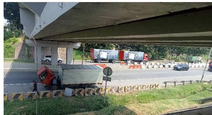
KONDISI BANGUNAN BAWAH
