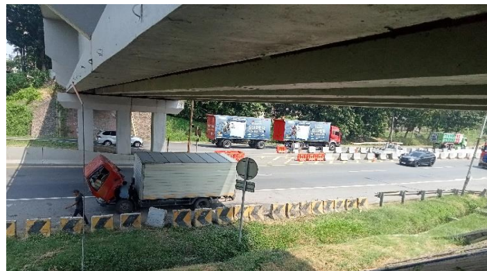
KONDISI BANGUNAN BAWAH
