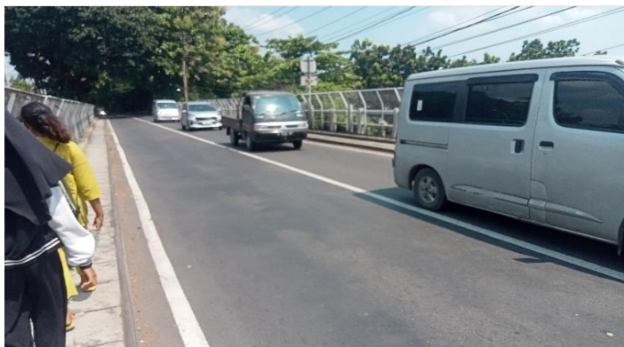
KONDISI LAPISAN PERMUKAAN LANTAI
