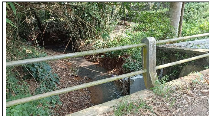
KONDISI SANDARAN JEMBATAN
