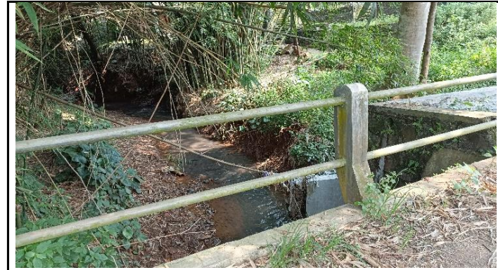
KONDISI SANDARAN JEMBATAN
