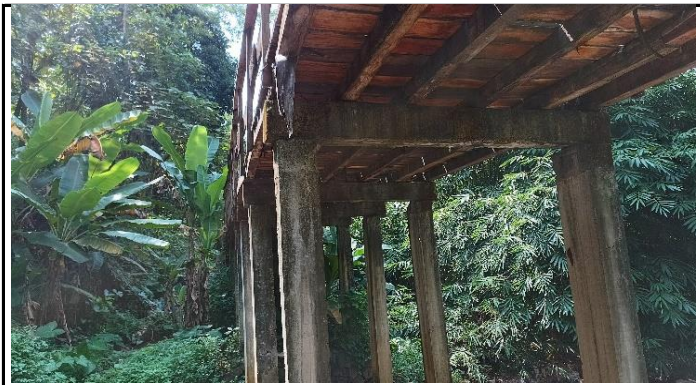
KONDISI GELAGAR KAYU DAN PILAR
