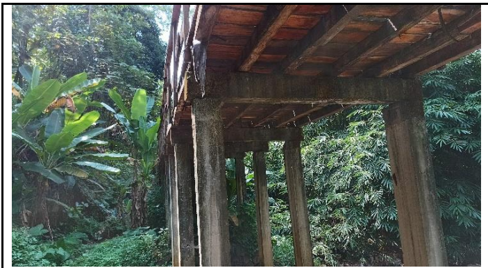
KONDISI GELAGAR KAYU DAN PILAR
