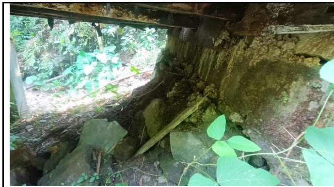
KONDISI KEPALA JEMBATAN
