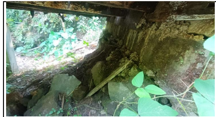
KONDISI KEPALA JEMBATAN
