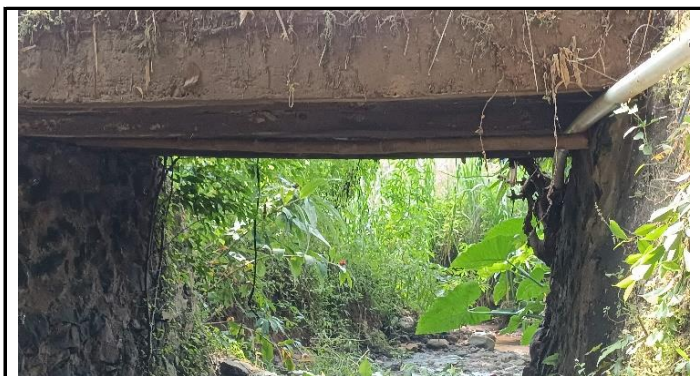
KONDISI GELAGAR BETON
