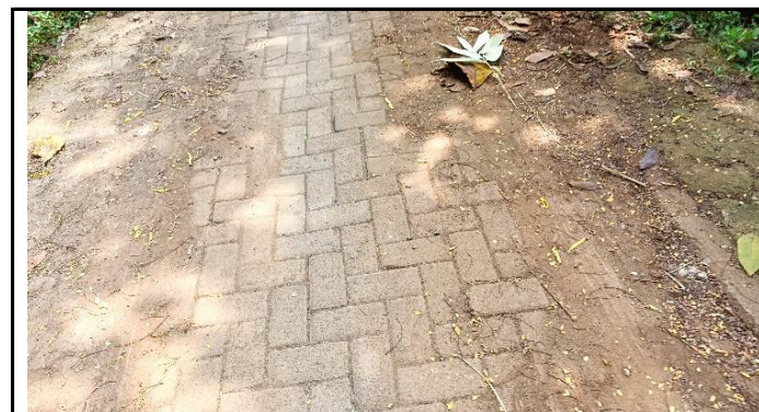
KONDISI LANTAI JEMBATAN
