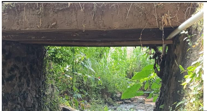
KONDISI GELAGAR BETON
