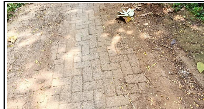
KONDISI LANTAI JEMBATAN
