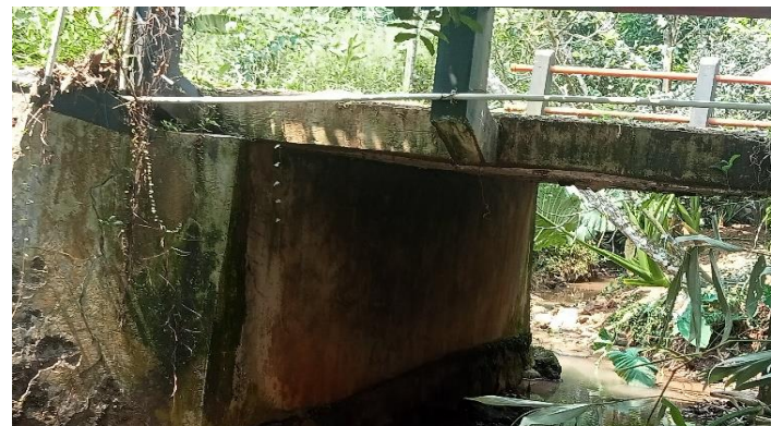
KONDISI BANGUNAN BAWAH
