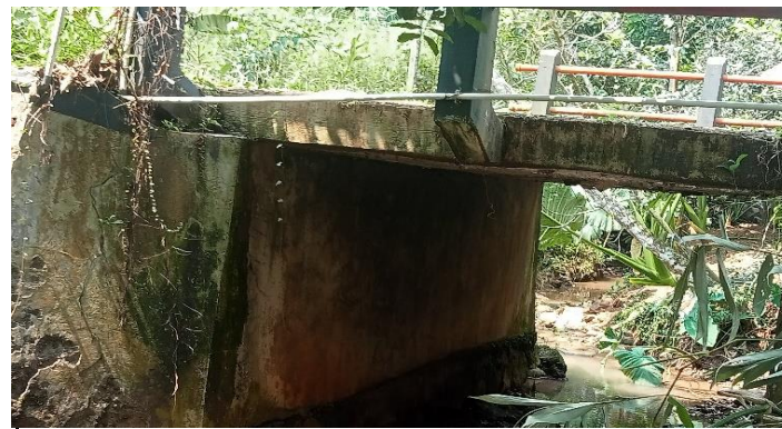
KONDISI BANGUNAN BAWAH
